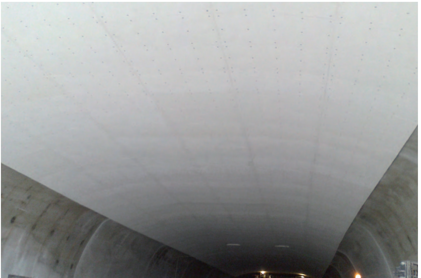
Schutz vor Versagen der Betonstruktur
